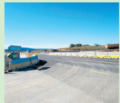
Inici de les obres de la rotonda a l'N-340
