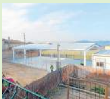
Pista amb coberta a l'escola Subirats de Lavern
