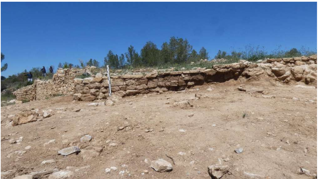
Figura 58. Cara externa descoberta de la torre geminada
