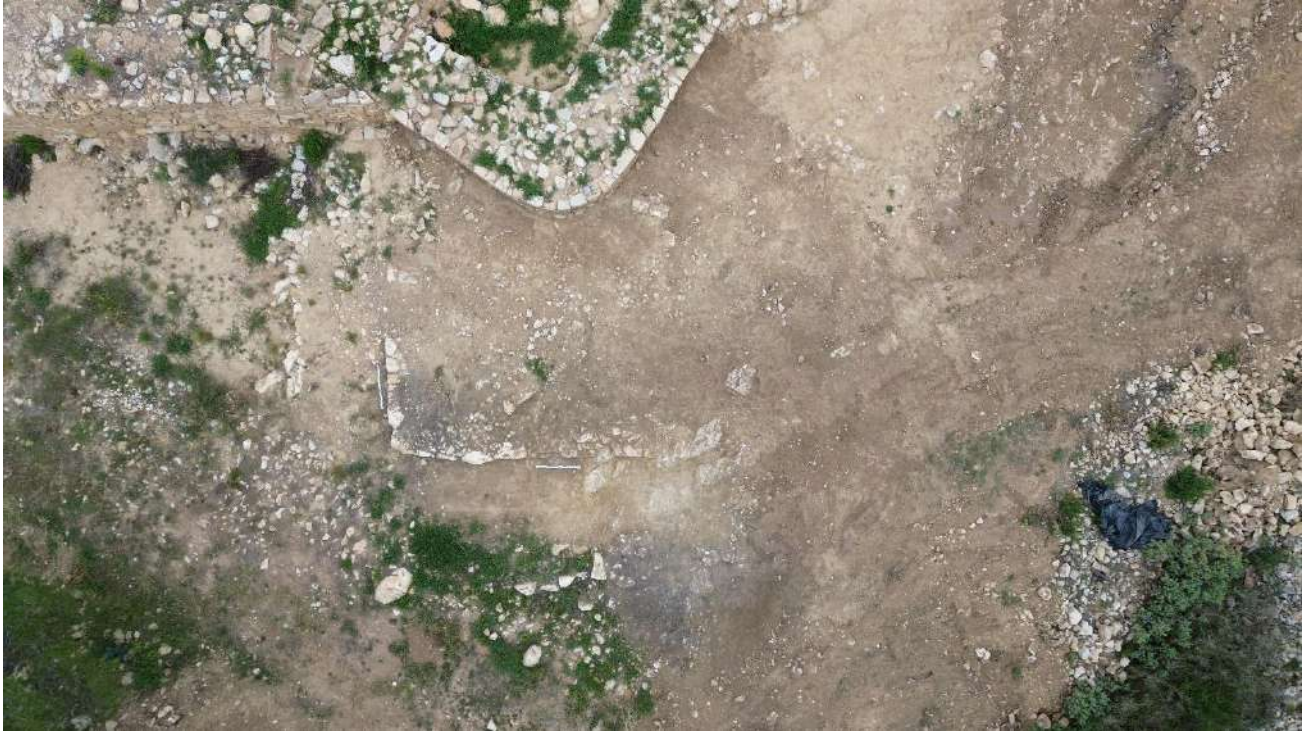
Figura 57. Vista àeria de la rampa i l'angle recte
